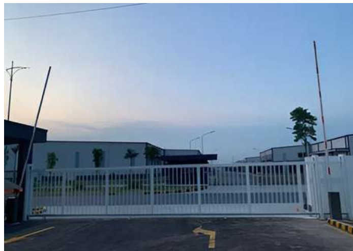
Lắp đặt cổng trượt tự động và barie tự động KCN Cẩm Điền, Hải Dương
