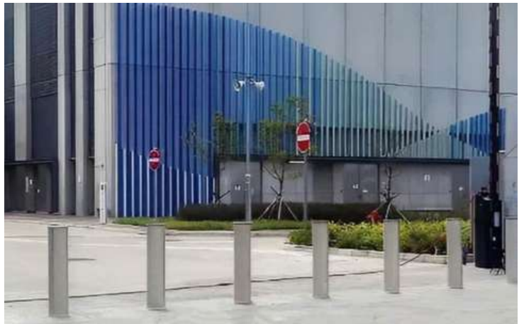
Hệ thống kiểm soát an ninh lắp đặt tại Khu công nghệ cao Hòa Lạc
