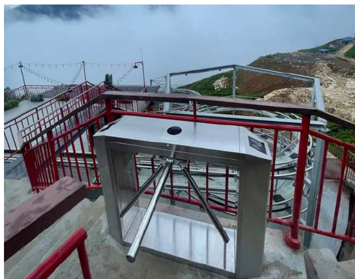
Hệ thống cửa phân làn kiểm soát vé Khu nghỉ dưỡng cao cấp Bản Mòng
