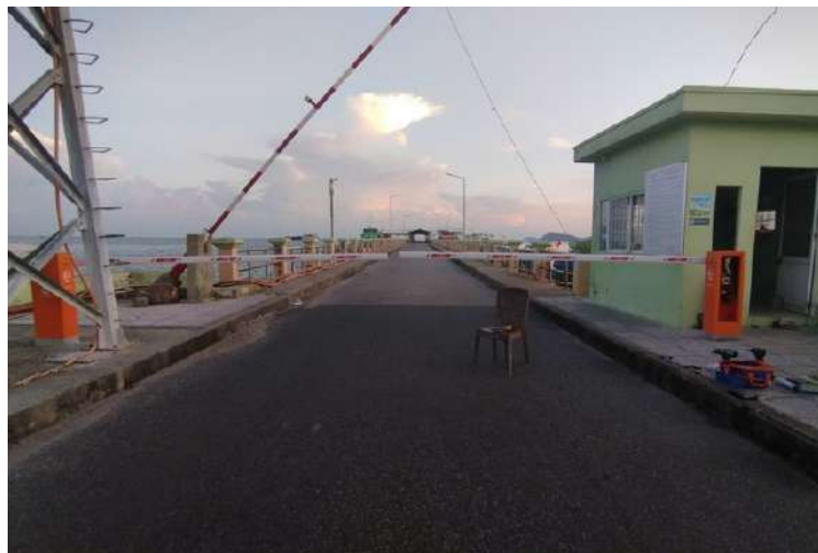
Lắp đặt Barie tự động Cảng Phú Quốc
