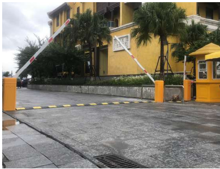
Hệ thống kiểm soát phương tiện Cảng Quốc tế Hạ Long
