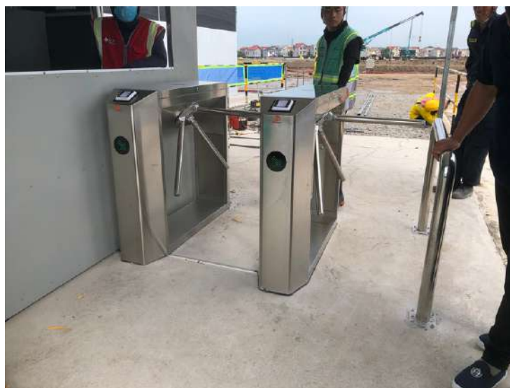
Hệ thống kiểm soát vào ra công trường Công trường Cotecons Bắc Ninh
