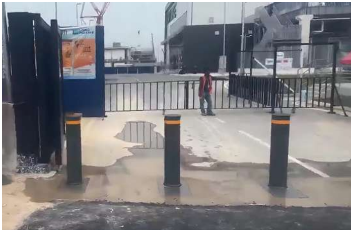
Hệ thống kiểm soát an ninh lắp đặt tại Khu công nghiệp Vsp Hải Dương
