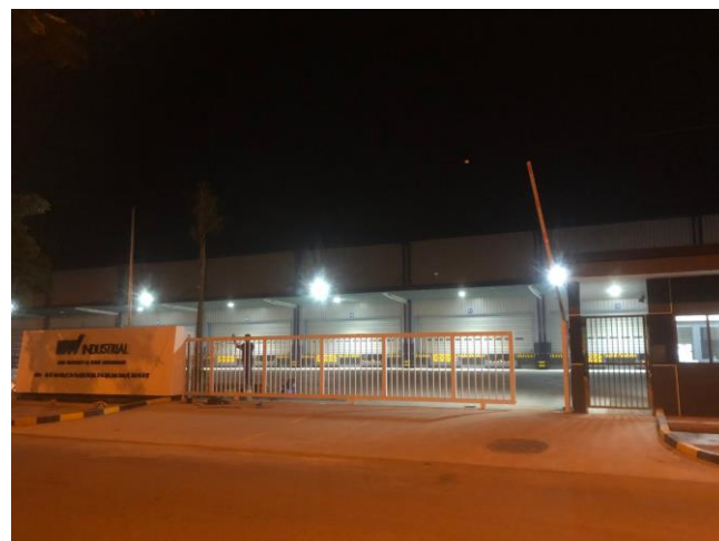
Lắp đặt cổng trượt tự động và barie cho nhà máy BW Phú Nghĩa
