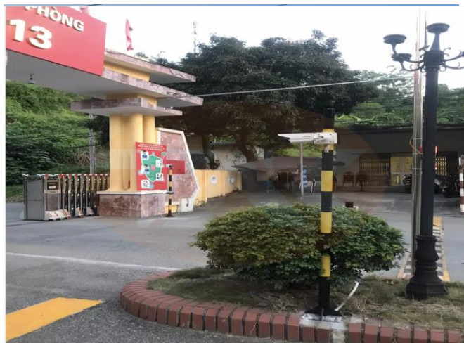
Hệ thống kiểm soát phương tiện ra vào cho nhà máy Z113 Tuyên Quang
