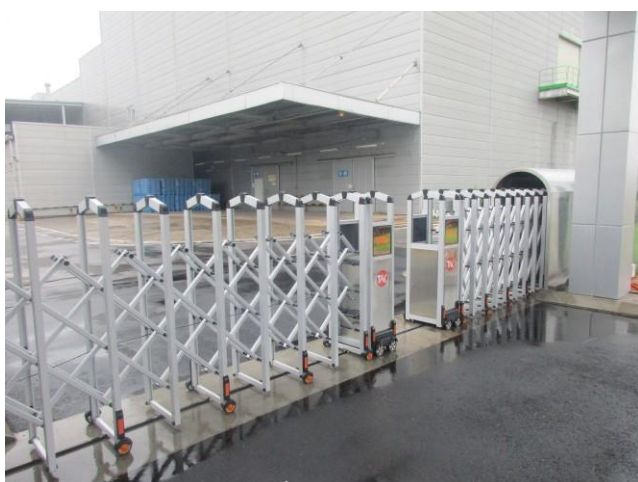
Nhà máy Samsung KCN Yên Bình, Phổ Yên, Thái Nguyên
