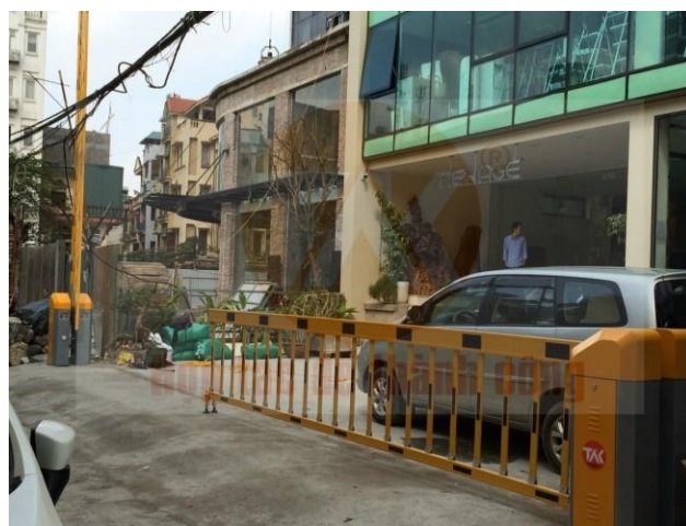
Lắp đặt Rào chắn Barie tự động cho tòa nhà 536 Kim Mã, Hà Nội
