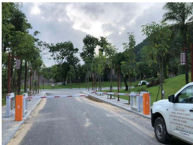
Lắp đặt cửa phân làn Swing barie và barie tự động tại Suối Bang – Quảng Bình
