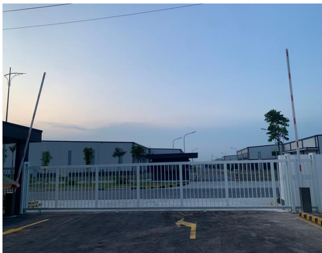
Lắp đặt cổng trượt tự động và barie tự động tại KCN Cẩm Điền, Hải Dương
