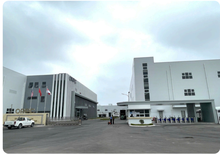
Cổng xếp inox và hệ thống cửa ACM kiểm soát ra vào, chấm công tại nhà máy ORPC Hải Phòng
