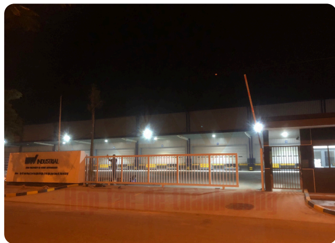
Lắp đặt cổng trượt tự động và barie Nhà máy BW Phú Nghĩa
