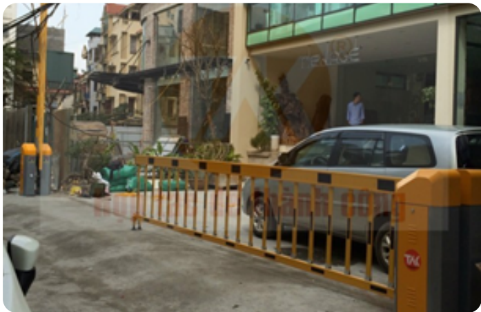
Lắp đặt Rào chắn Barie tự động tòa nhà 536 Kim Mã, Hà Nội
