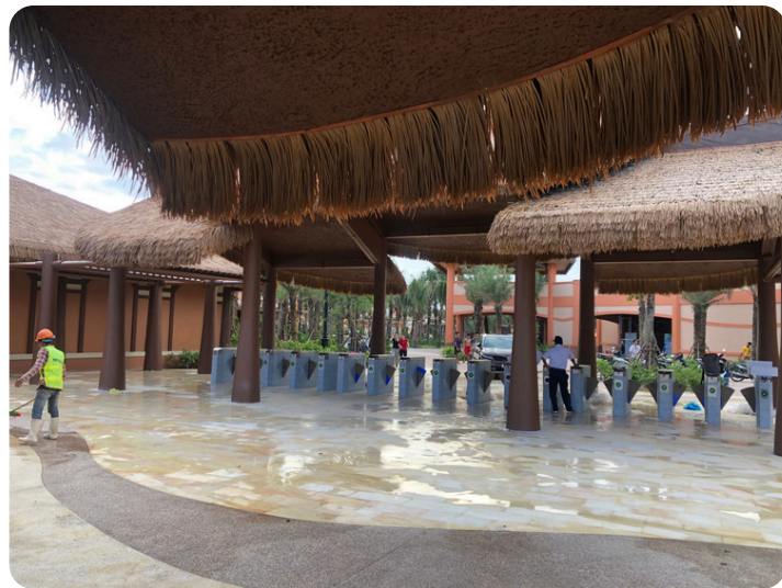
Hệ thống kiểm soát vé ra vào Khu công viên nước Sun Sầm Sơn
