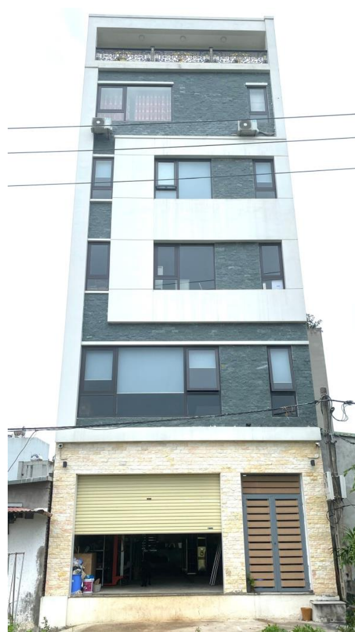
Xưởng sản xuất và Showroom
