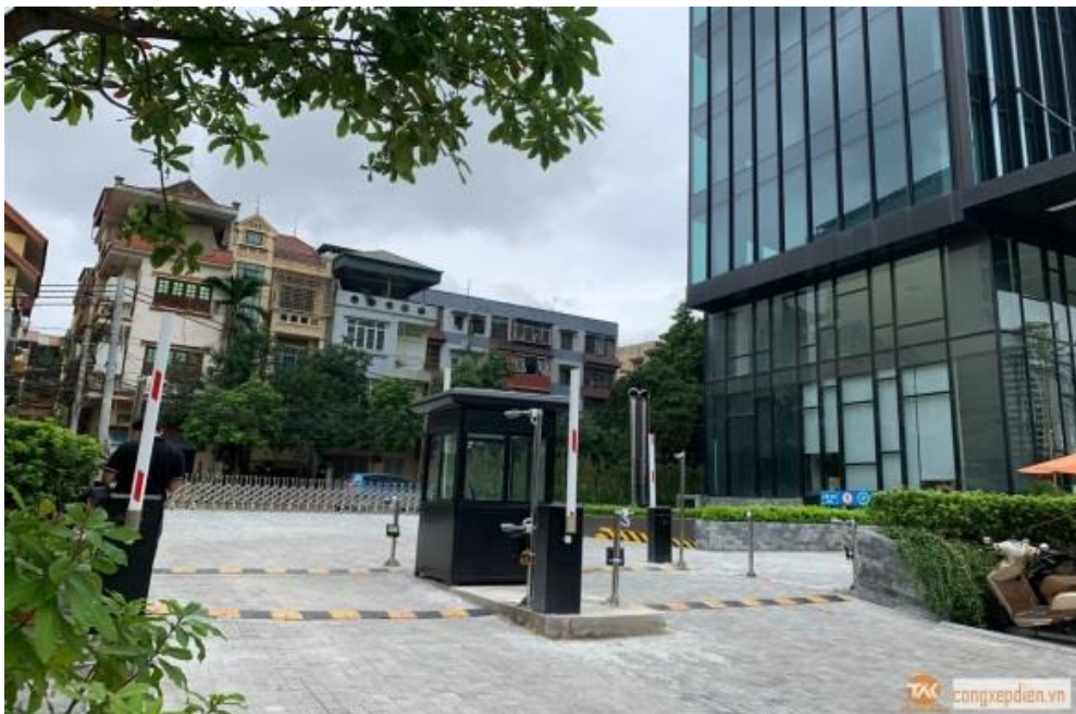
Tòa nhà Leadvisors - Tower Hệ thống kiểm soát xe
